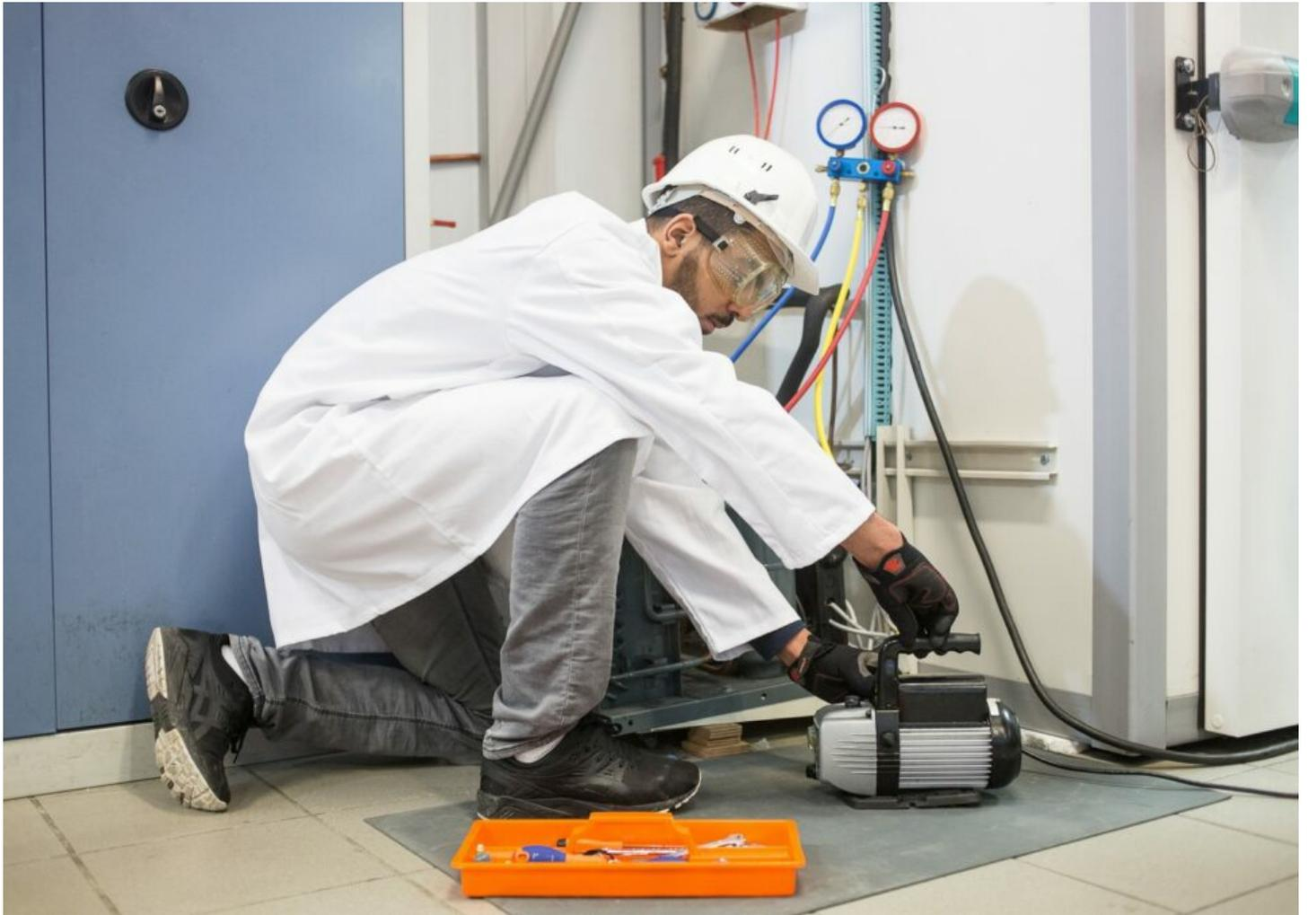
*Mise au vide d'un circuit frigorifique à l'aide d'un manomètre dans une chambre froide.*
