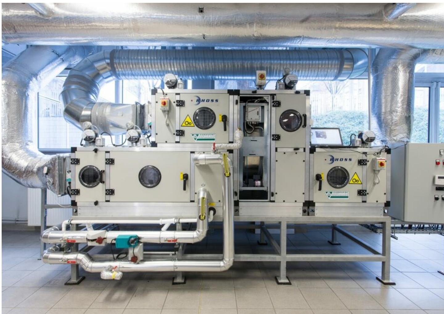
*Centrale de traitement de l'air avec roue de récupération énergétique (FCA).*
