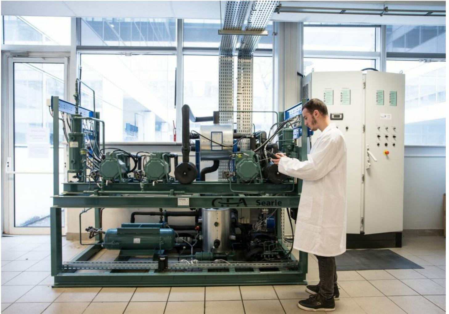
*Mesure de la température, aspiration et compression sur une centrale frigorifique CO2.*
