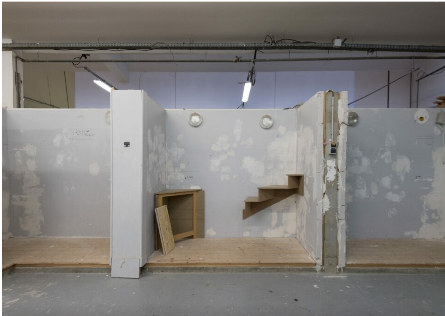
Cellules de pose utilisées par les stagiaires du module menuiserie.
