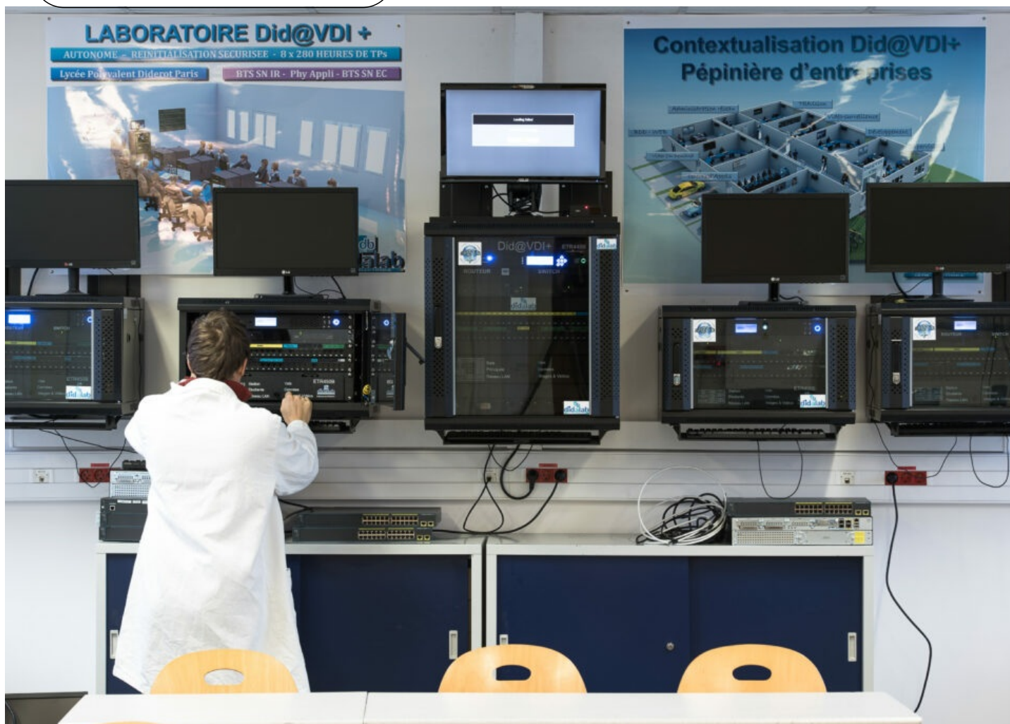
Intervention sur un serveur par un stagiaire TSRIT dans le Laboratoire Réseaux Voix Données Images.
