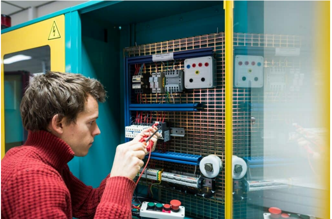
Câblage d'une platine industrielle sur une armoire de test de platine.
