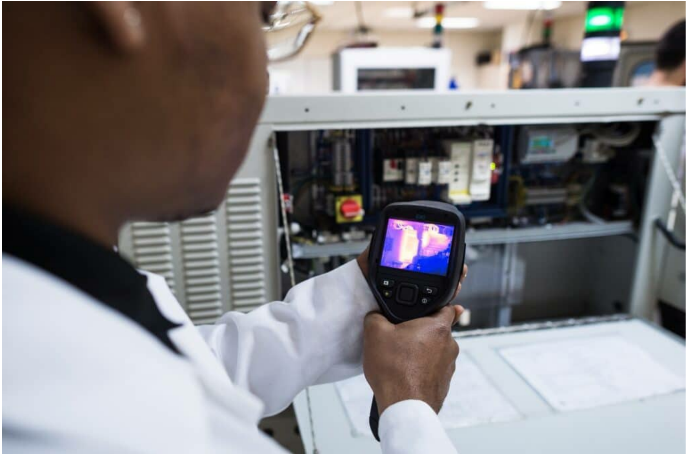
Analyse thermographique par un stagiaire du BTS Maintenance des systèmes sur la déchiqueteuse.
